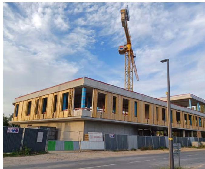
Chantier en cours
