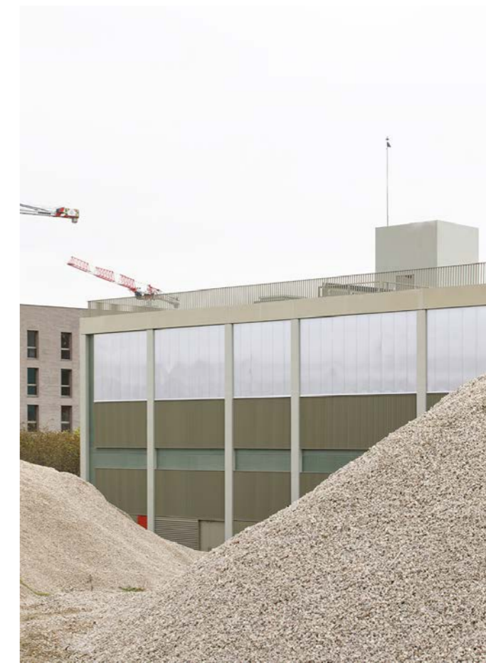
Chaufferie livrée en 2022
